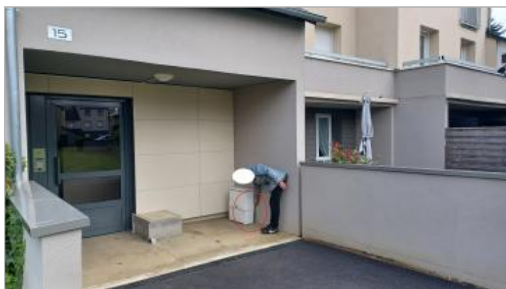
Laisse de crue à 17.5 cm/sol
