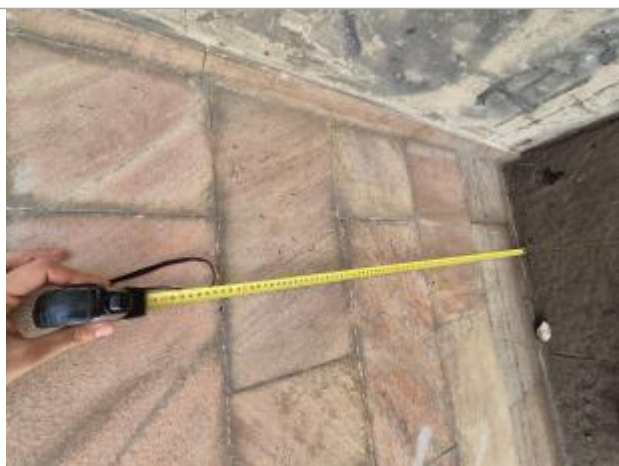
Dépôts de matières solides
