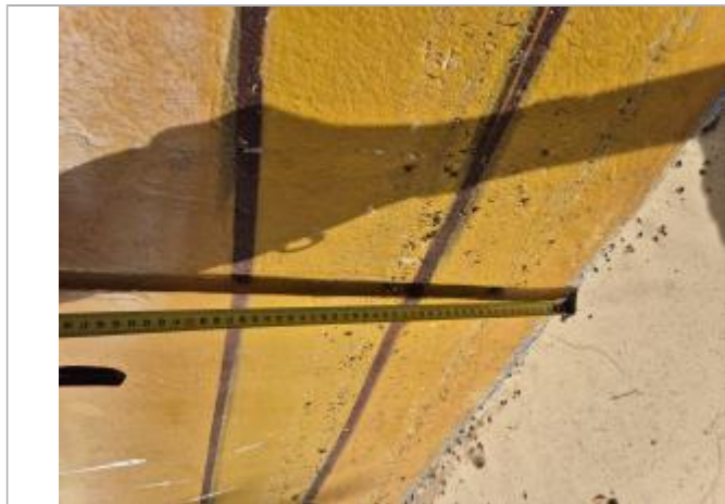
Dépôts de matières solides
