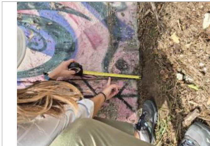
Dépôts de matières solides
