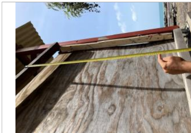
Mesure depuis la poutre en bois
