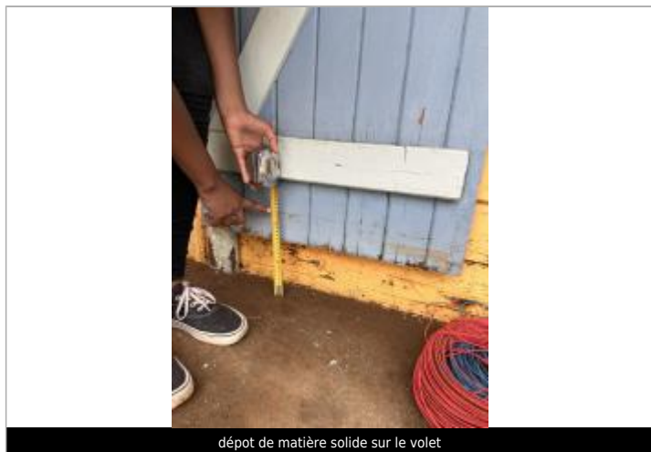
dépot de matière solide sur le volet
