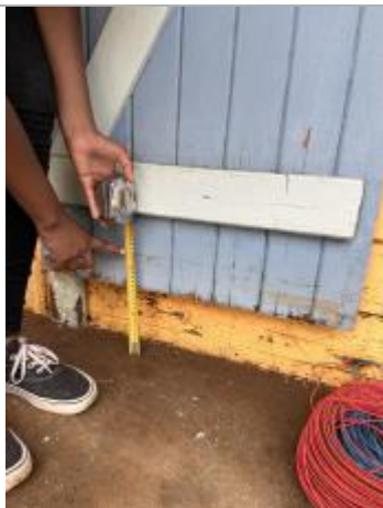
dépot de matière solide sur le volet
