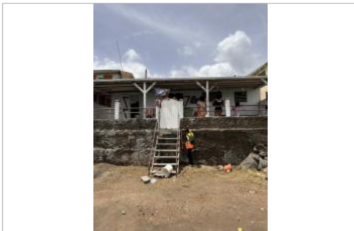
Bâti façade littorale avec escalier en métal
