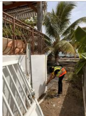
Mur de la terrasse façade littorale
