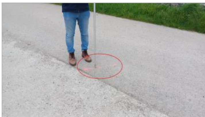
laisse de crue au sol
