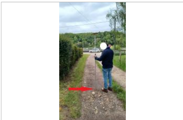
Laisse de crue au sol.
