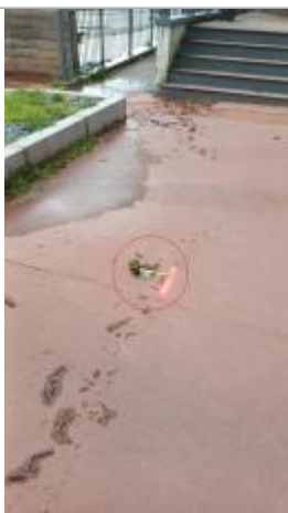
Laisse de crue au sol
