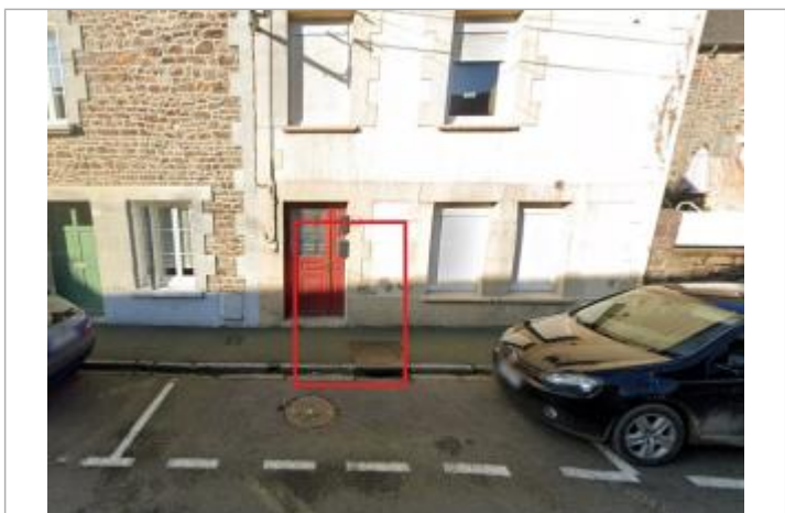
Porte d'entrée de la maison au 83 rue Paul Langevin
