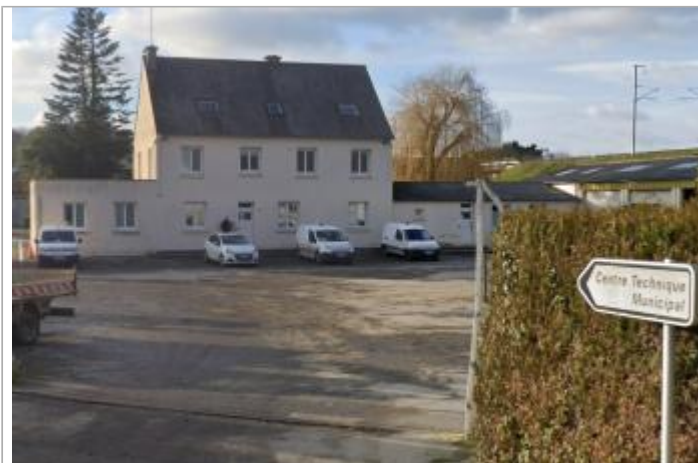
Centre technique municipal - vestiaires
