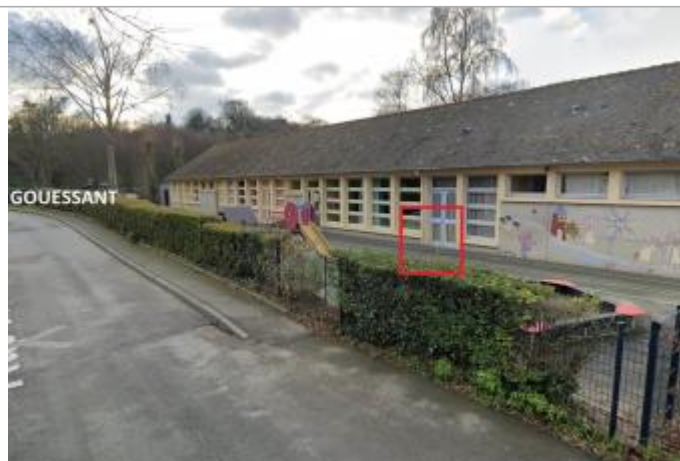
Seuil d'une des portes d'entrée de l'école Lavergne
