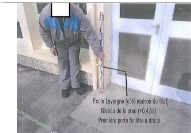
Seuil d'une des portes d'entrée de l'école Lavergne
