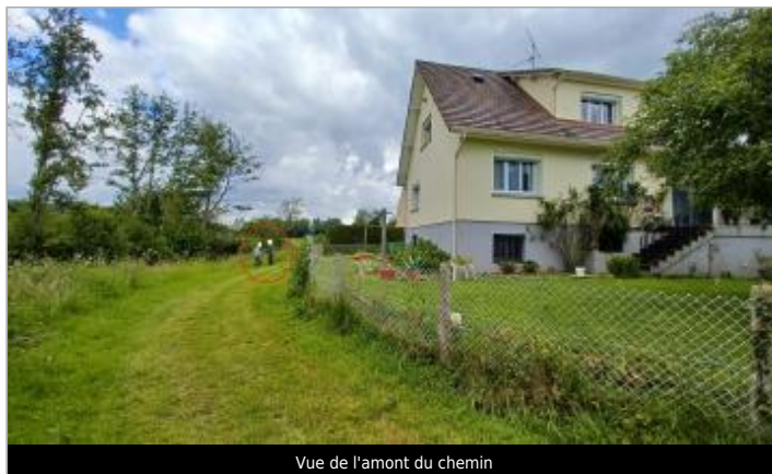
Vue de l'amont du chemin
