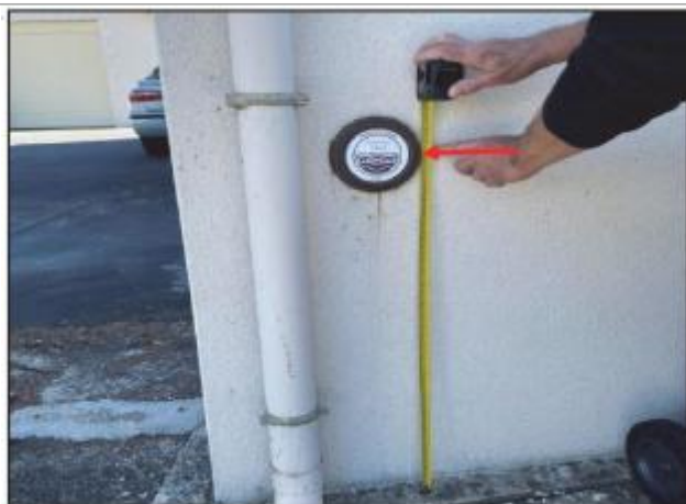
Photo du repère - Auteur : DHE
