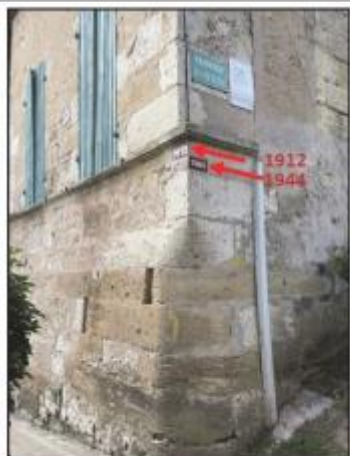
Photo du repère - Auteur : DHE
