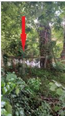
Laisse de crue au sol
