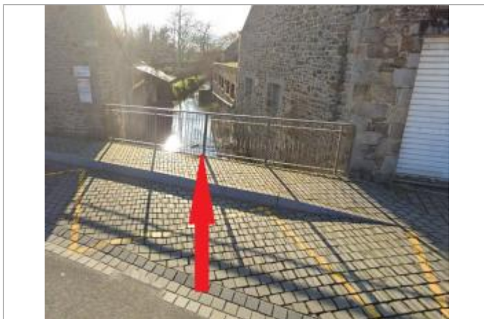
Pont sur le Guessant rue du général Leclerc
