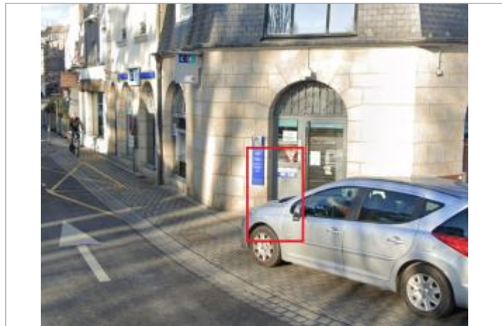
Seuil porte d'entrée agence bancaire
