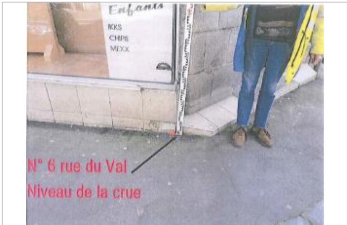
Trottoir devant la porte d'entrée d'un magasin au 6 rue du Val
