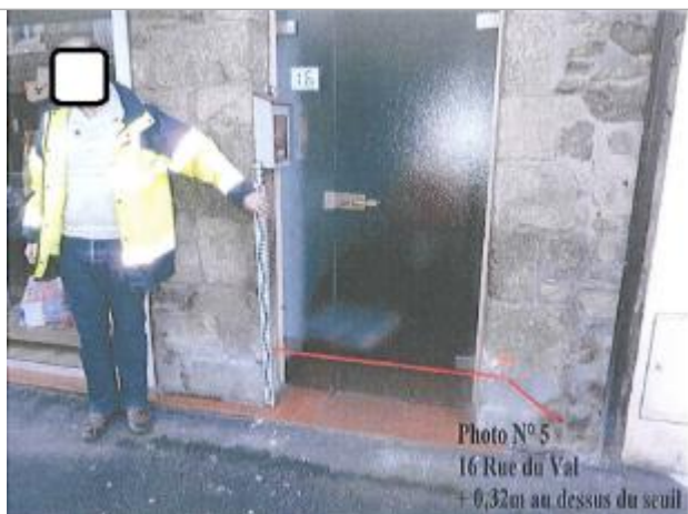
Porte d'entrée magasin au 16 rue du Val
