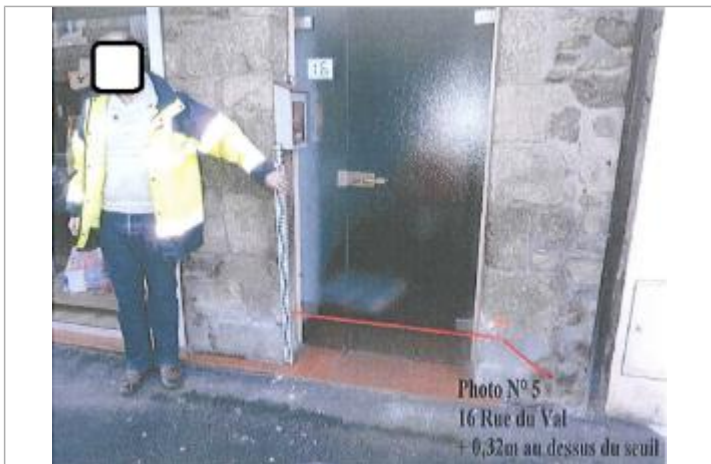
Porte d'entrée magasin au 16 rue du Val
