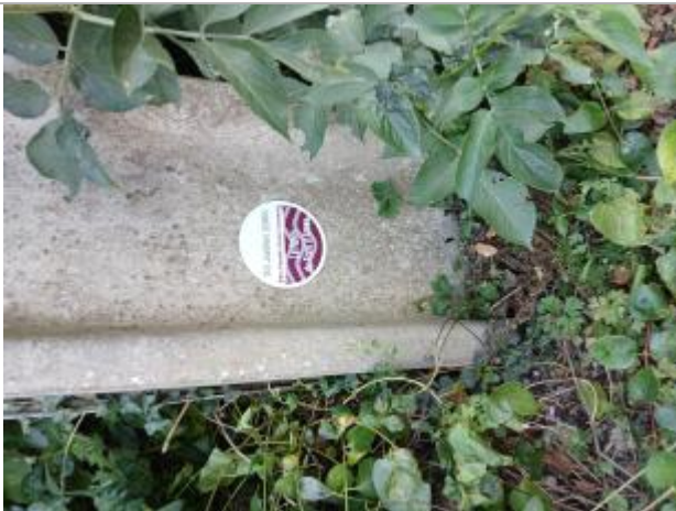
Le repère de crue
