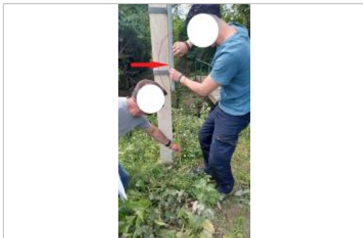
Laisse de crue à 118 cm/sol.
