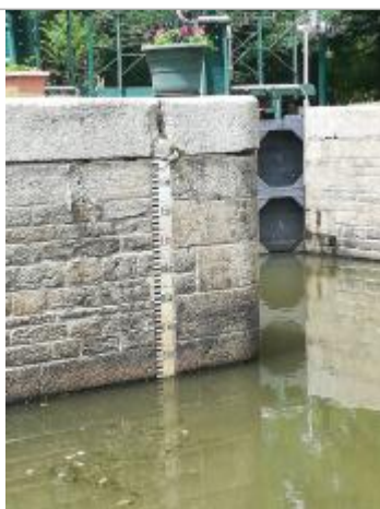
Echelle aval de l'écluse de la Maclais
