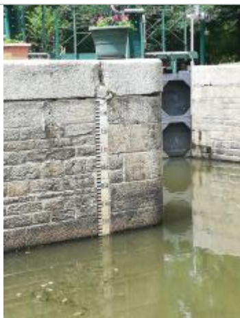
Echelle aval de l'écluse de la Maclais
