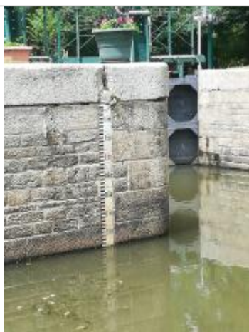
Echelle aval de l'écluse de la Maclais
