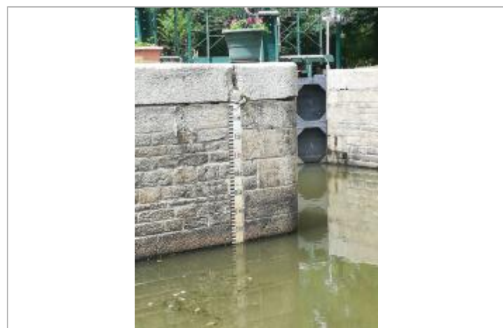
Echelle limnimétrique aval de l'écluse de la Maclais
