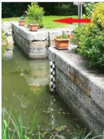
Echelle amont de l'écluse de la Maclais
