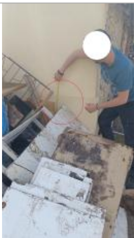
Laisse de crue à 80 cm/sol
