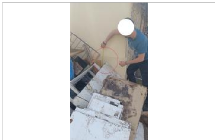
Laisse de crue à 80 cm/sol
