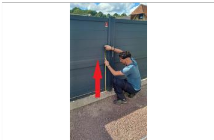
Laisse de crue à 88.5 cm/sol
