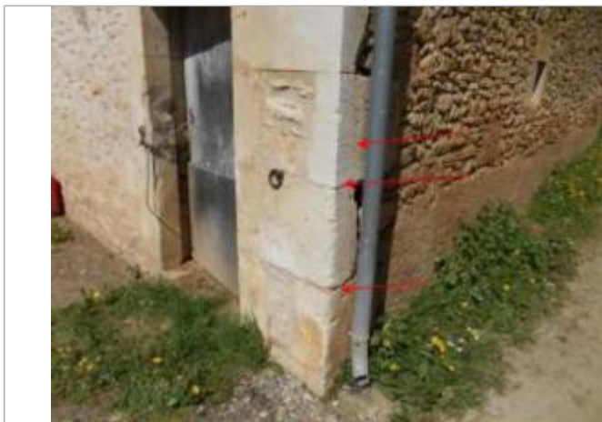
Vue des repères
