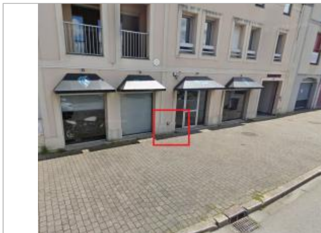
Immeuble au 8 rue du capitaine Martin
