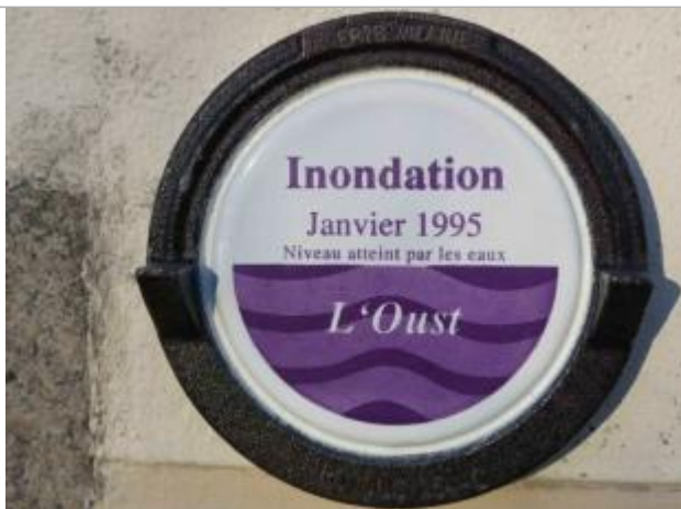
Repère normalisé de la crue de janvier 1995
