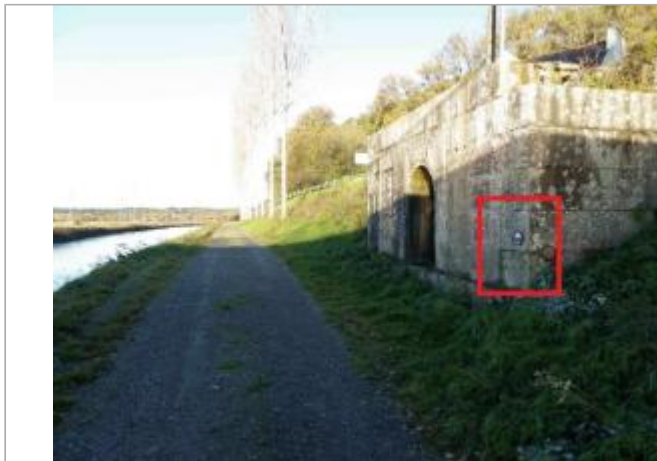
Ancienne pile de pont, rue du Paradet
