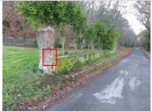
Poteau en 2010 avec repère
