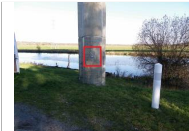
Pile du viaduc en 2010 avec repère
