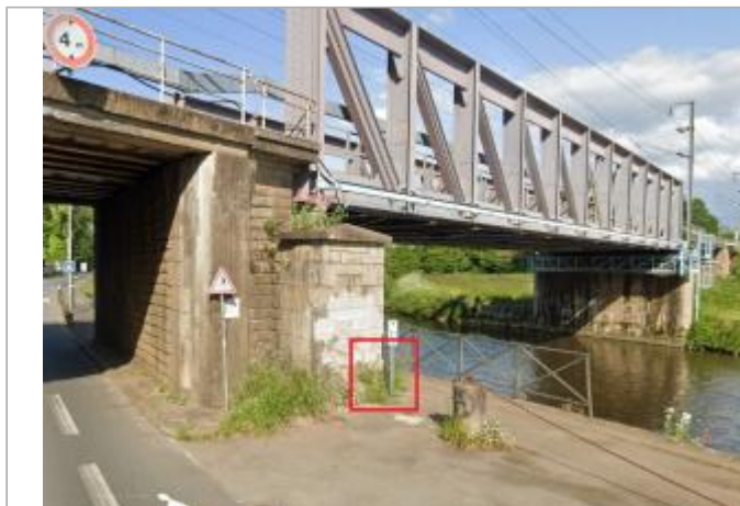
Pile du pont ferroviaire quai Saint-Jacques
