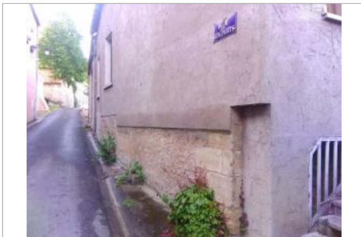
Vue du site - Auteur : SPC LACI
