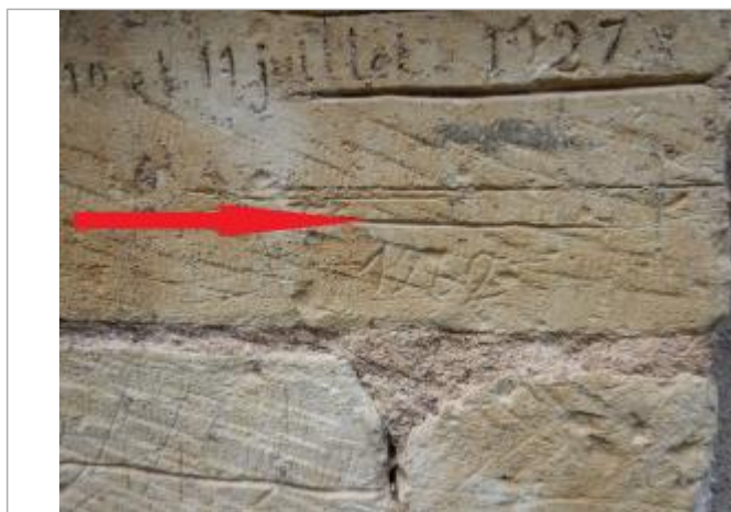
Vue du repère - Auteur : SPC LACI
