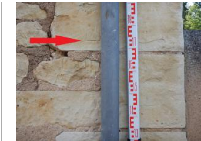
Vue du repère - Auteur : SPC LACI
