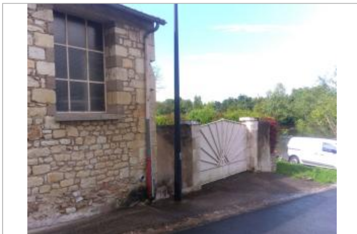
Vue du site - Auteur : SPC LACI
