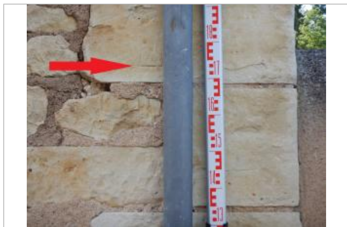
Vue du repère - Auteur : SPC LACI
