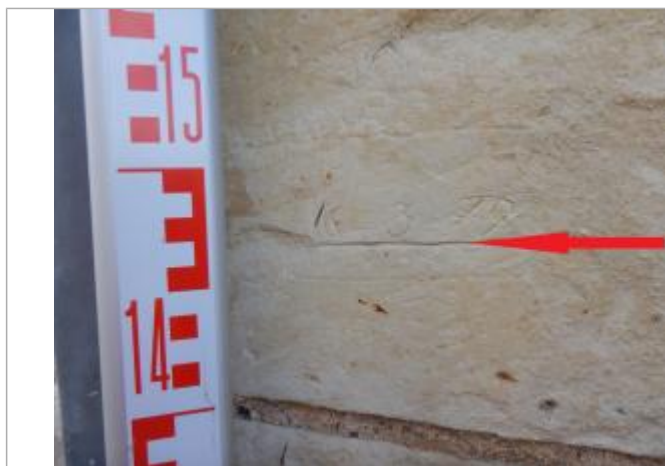
Vue du repère - Auteur : SPC LACI
