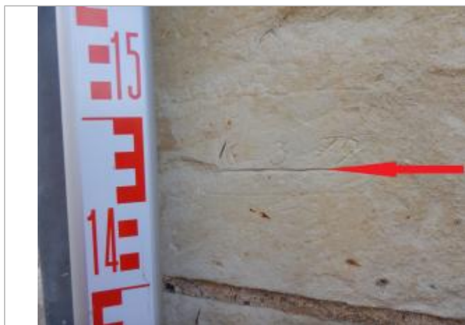
Vue du repère - Auteur : SPC LACI
