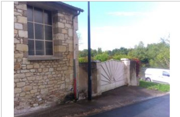
Vue du site - Auteur : SPC LACI
