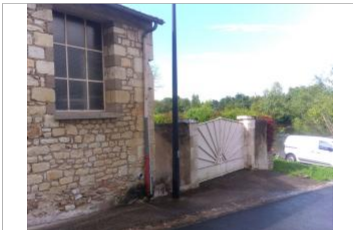
Vue du site - Auteur : SPC LACI
