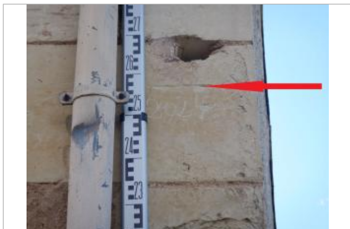
Vue du repère - Auteur : SPC LACI
