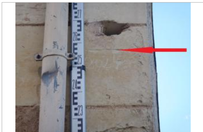
Vue du repère - Auteur : SPC LACI
