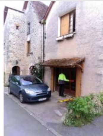
Vue du site - Auteur : SPC LACI
