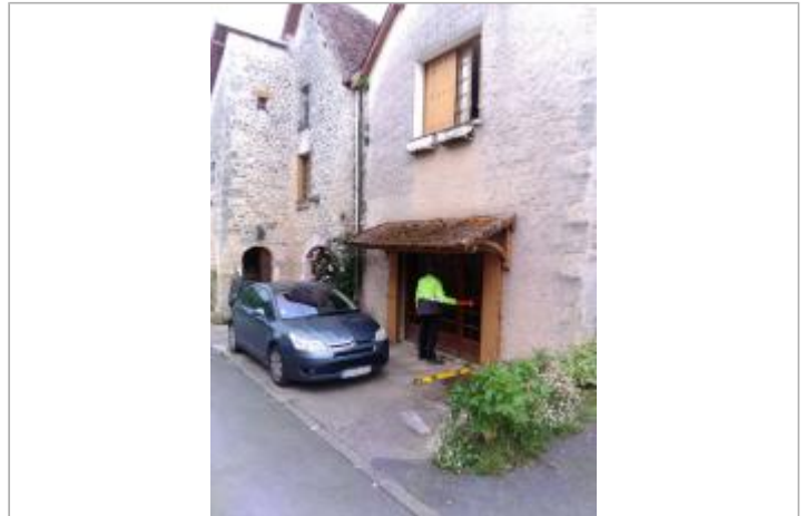
Vue du site - Auteur : SPC LACI
