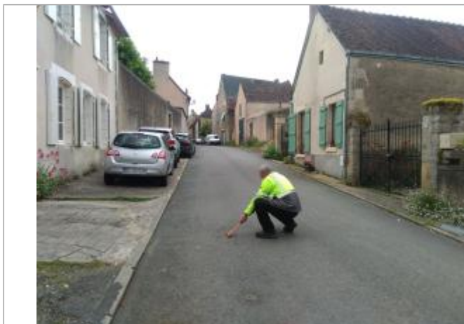
Vue du site - Auteur : SPC LACI
