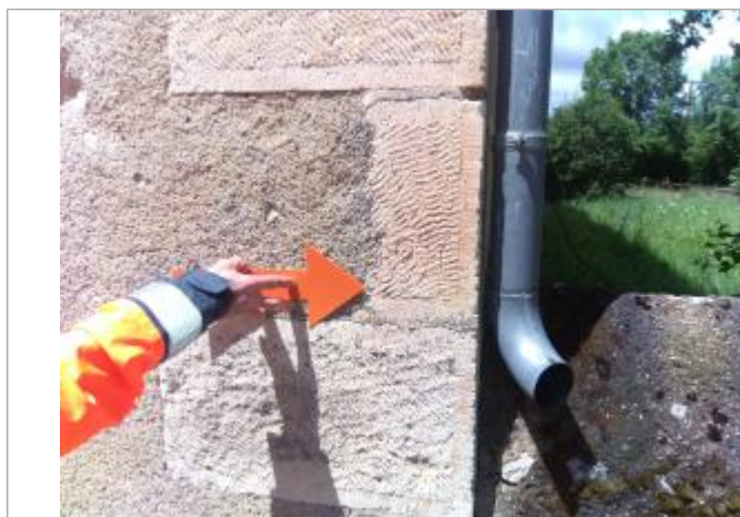
Vue du repère - Auteur : SPC LACI
