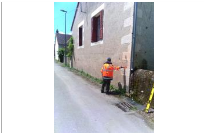
Vue du site - Auteur : SPC LACI
