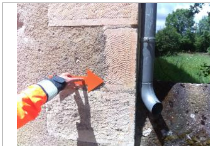
Vue du repère - Auteur : SPC LACI
