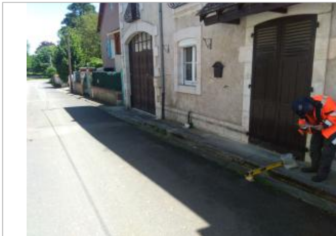
Vue du site - Auteur : SPC LACI
