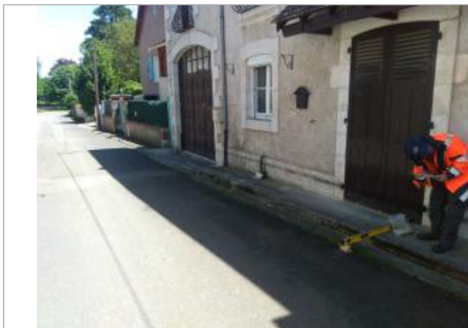
Vue du site - Auteur : SPC LACI
