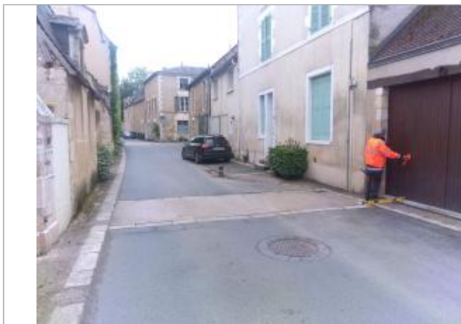
Vue du site - Auteur : SPC LACI
