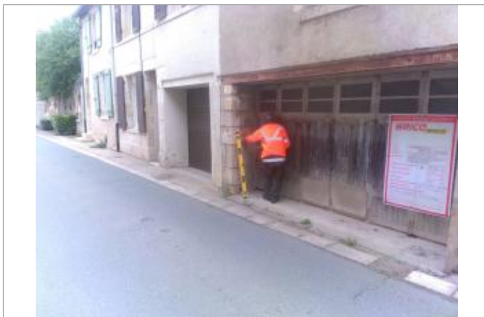
Vue du site - Auteur : SPC LACI
