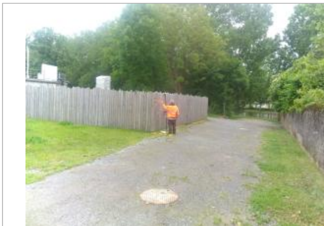
Vue du site - Auteur : SPC LACI
